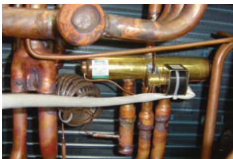
Электроннорасширительный клапан
