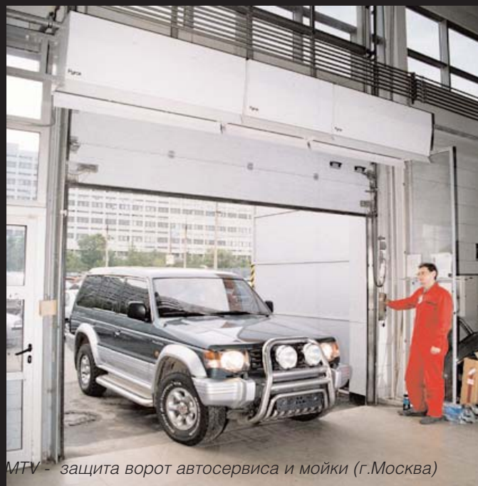
MTV - пример горизонтального монтажа. Ворота гаражных помещений
