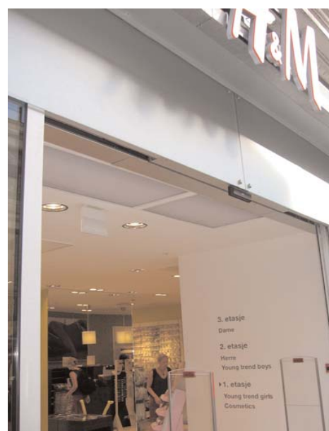
Пример монтажа воздушных завес HD в подвесном потолке.
